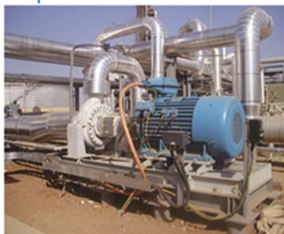
南非现场 South Africa Site
