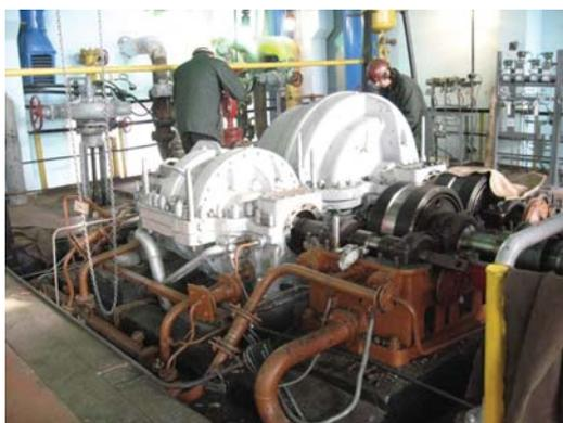
Trabajo casi listo. El trabajo completo incluyó la remoción del sello húmedo, modificación del sistema de lubricación, instalación del sello seco de gas, balanceo del rotor, instalación del panel de control, conexión del suministro de nitrógeno, conexión de cables.
