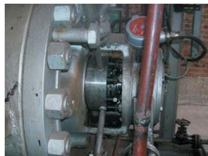
*"...Los sellos SD en tándem (API plan 52) funcionan bien en las bombas de residuos calientes sin líquidos barrera ni refrigeración adicional y muestran la misma durabilidad que los sellos instalados anteriormente por Sealol (Reino Unido)"*
